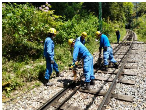
軌道バラスト道床整備
