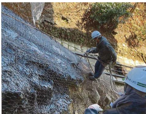
法面石積補強工事
